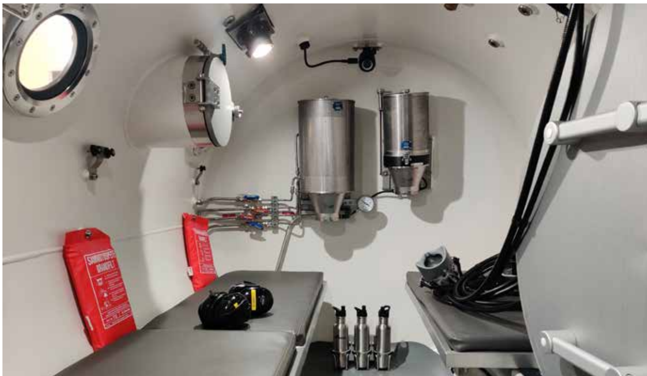
Till systemet hör en tryckkammare som används för att förhindra och behandla dykarsjuka.
