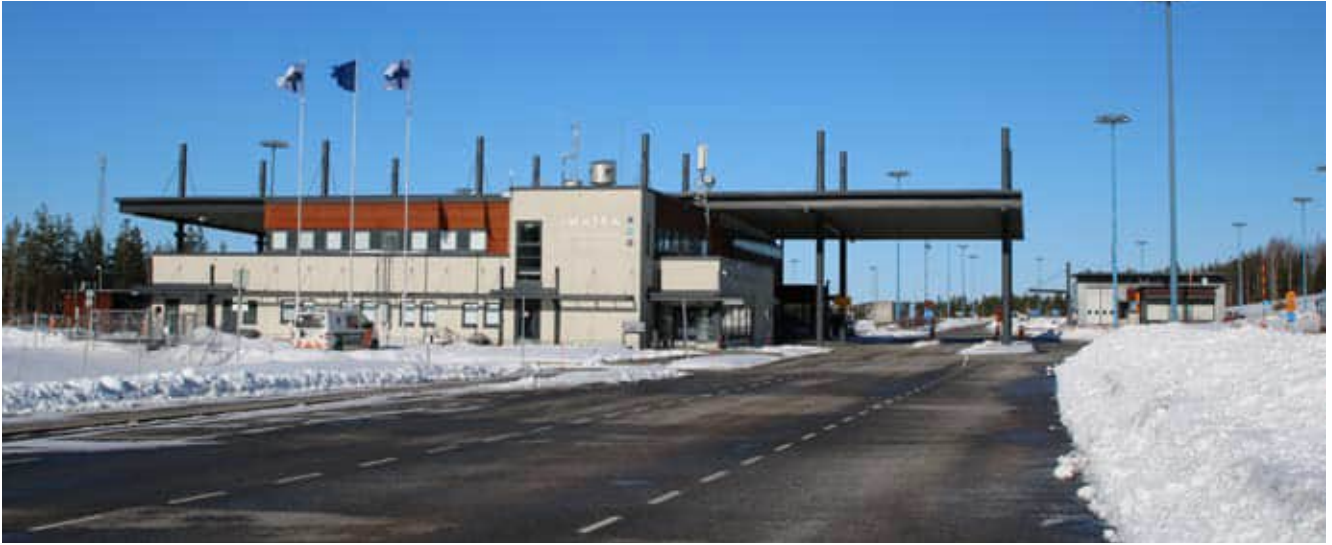
Imatran rajanylityspaikalla henkilöliikenne keskeytettiin kokonaan 31.1.2021 alkaen.
